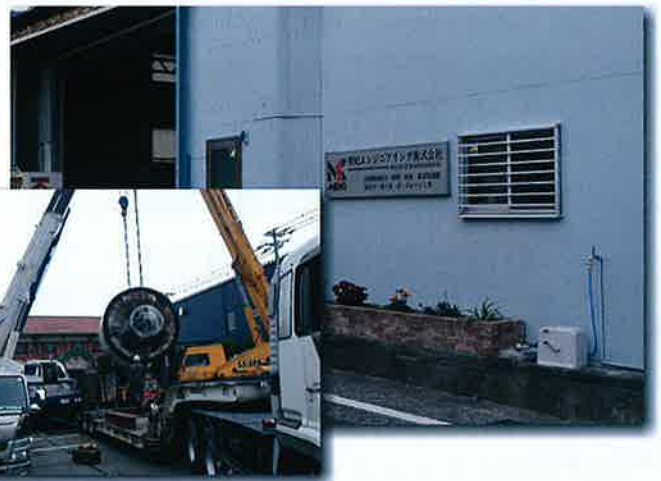
(会社外観と現場作業のようす)
