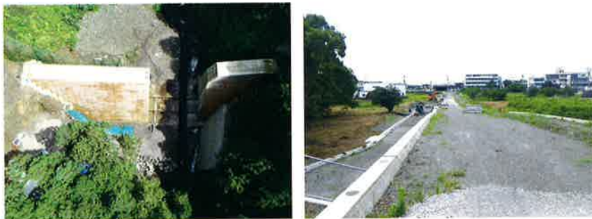
【建設中の砂防ダムと道路】
