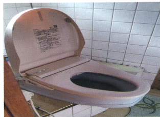
【トイレ水漏れ修理作業、 和式トイレをウォシュレットに】
